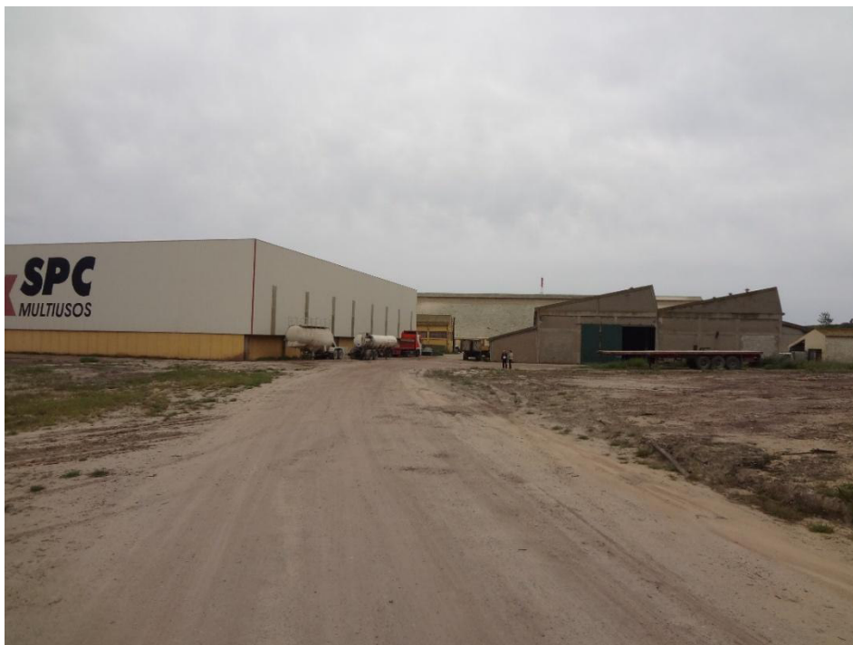
Imagem 1 Edifícios destinados à instalação da nova fábrica de enxofre
