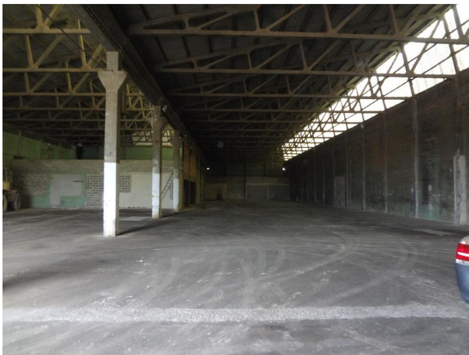
Imagem 10 Interior do edifício destinado a armazém da nova fábrica
