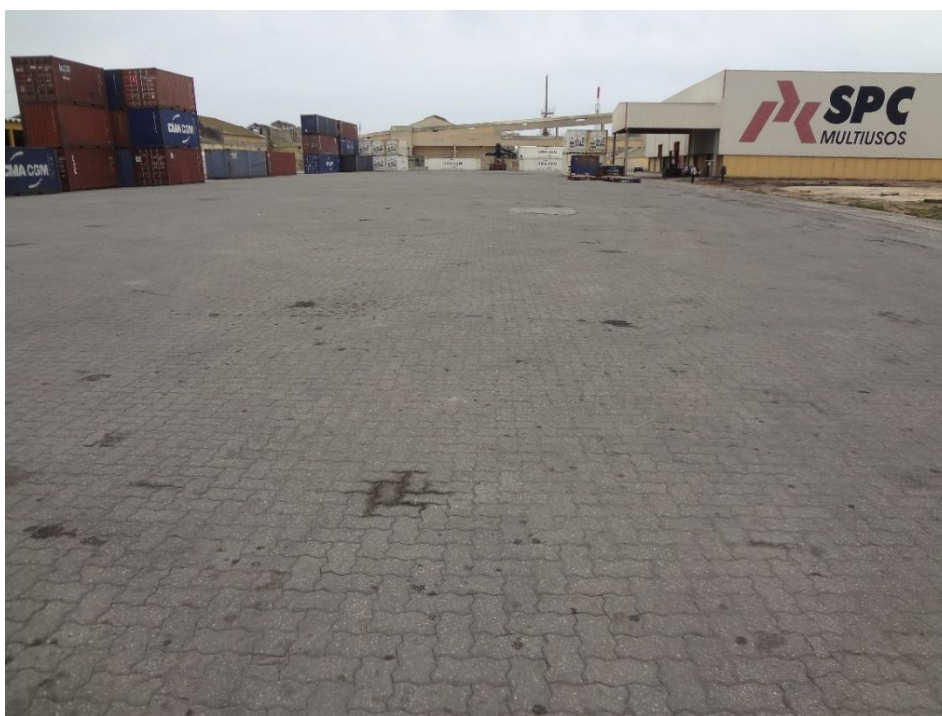
Imagem 2 Acesso aos edifícios destinados à instalação da nova fábrica de enxofre
