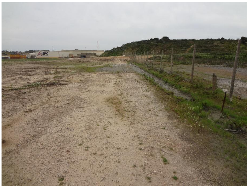
Figura 1 Zona de passagem da rede de abastecimento de água, gás natural e de drenagem de águas residuais domésticas
