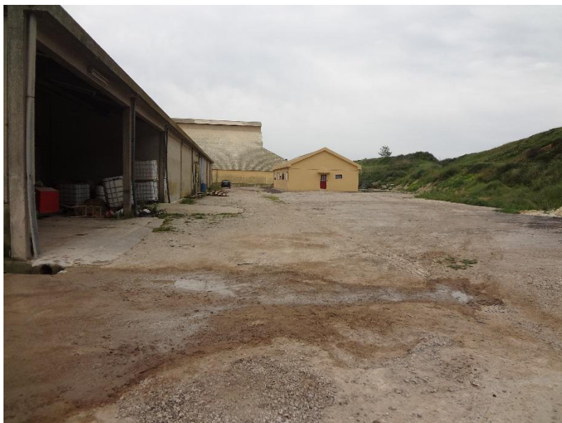
Figura 4 Área aplanada e impermeabilizada com tout-vennant
