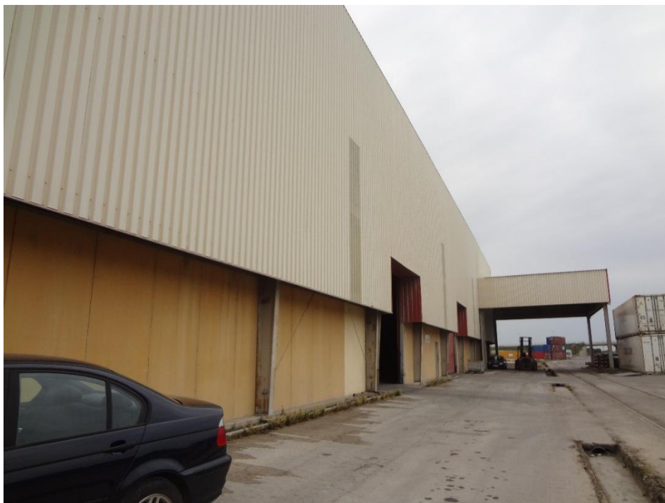
Imagem 3 Exterior do edifício destinado à unidade fabril
