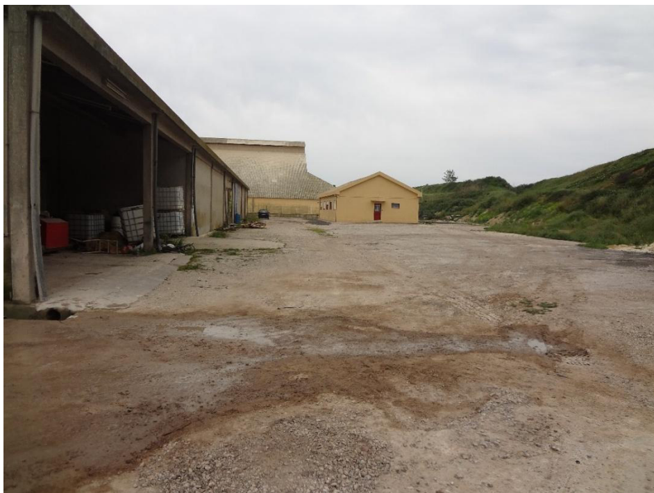
Imagem 11 Zona lateral do edifício destinado a armazém da nova fábrica, pavimentada com tout-venant
