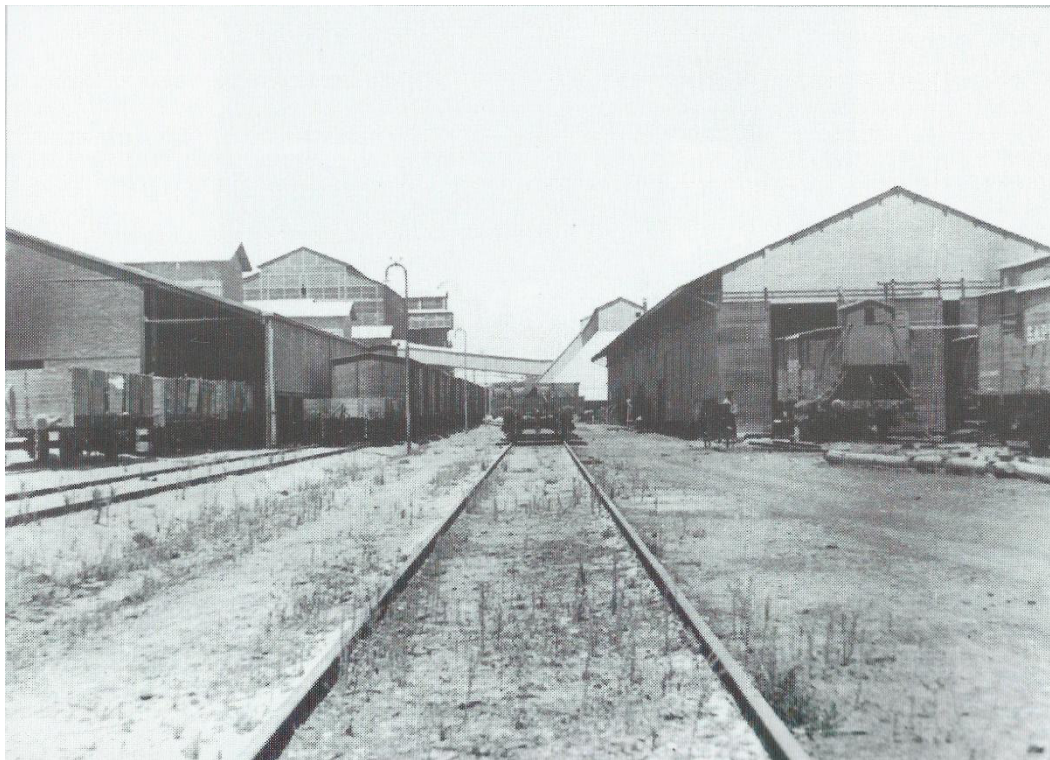
Figura 6 Edifícios que existiram na zona de desenvolvimento do projeto 1
