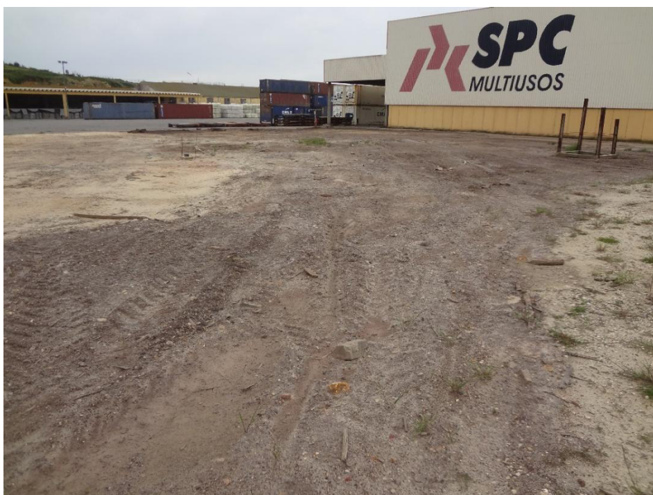
Imagem 14 Área de implementação do projeto, em frente aos edifícios destinados à instalação da nova fábrica – zona de maior concentração de cinza de pirite
