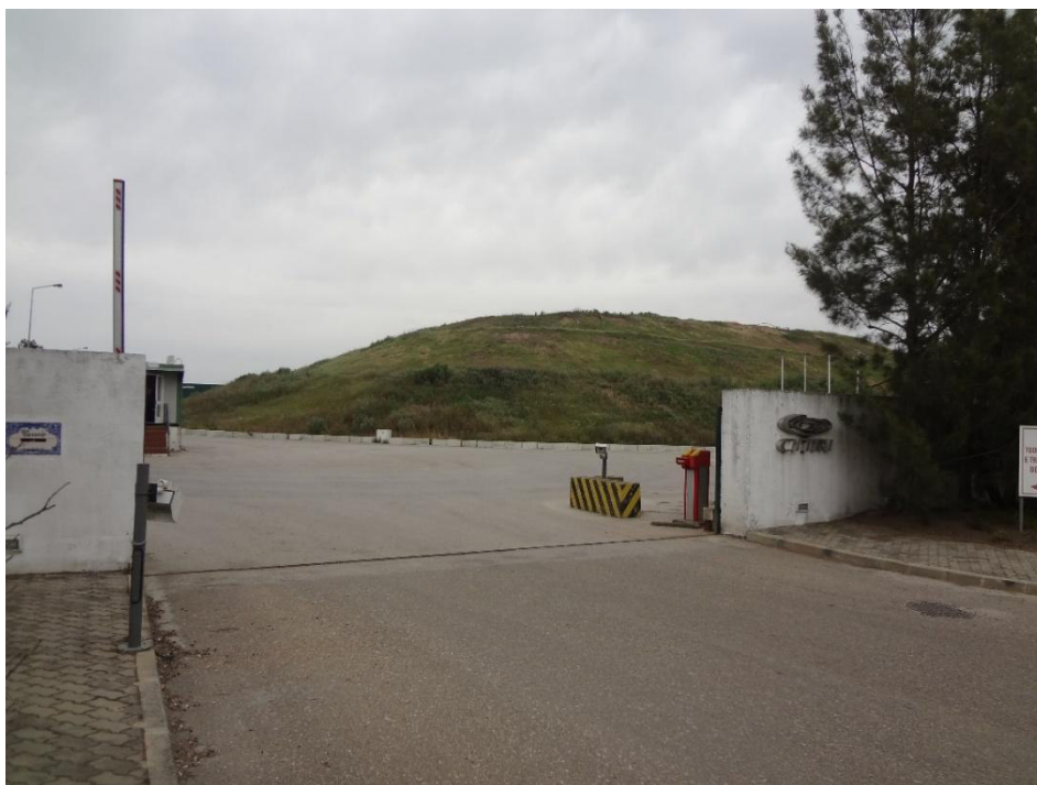
Figura 8 CITRI, aterro localizado no Parque Industrial, local do CNS 12137
