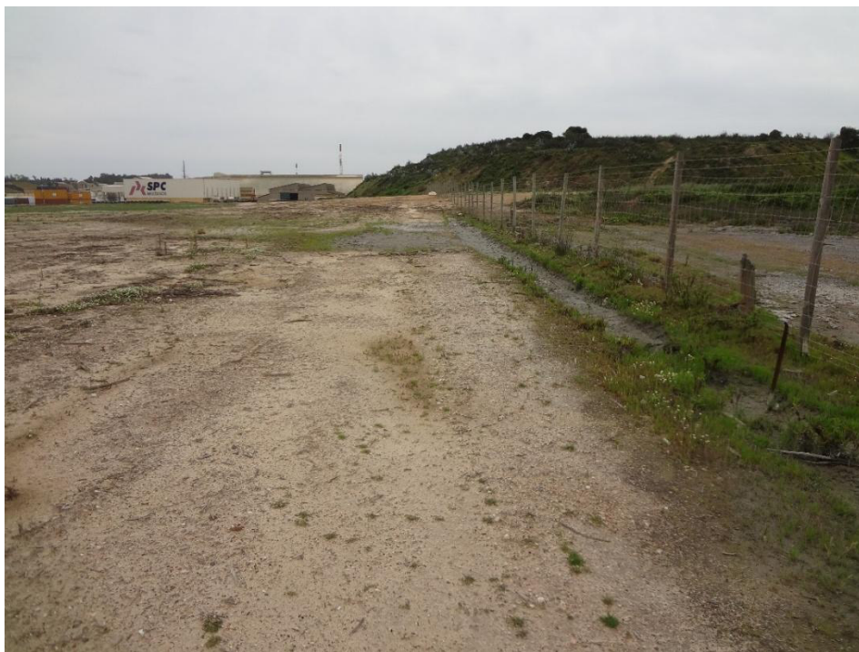
Imagem 17 Corredor destinado a infraestruturas de drenagem e abastecimento
