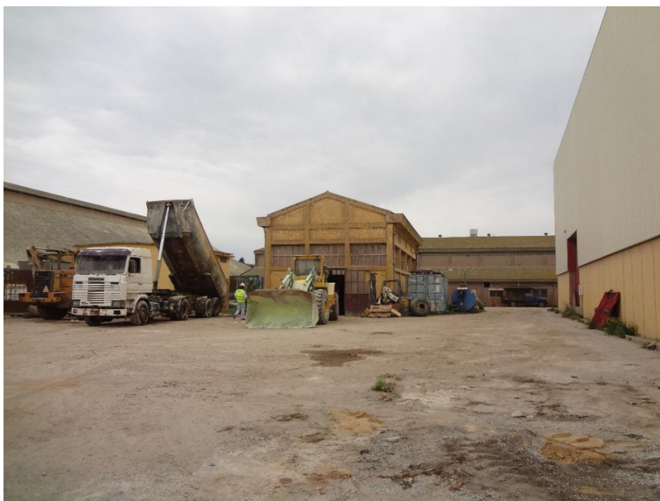
Imagem 6 Traseiras do edifício destinado à unidade fabril
