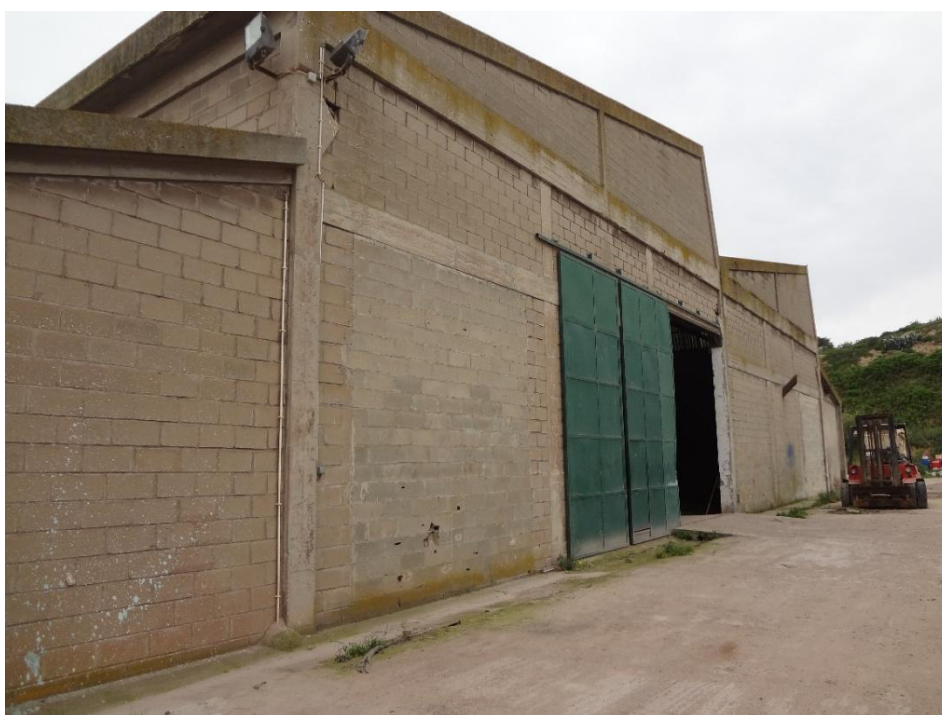
Imagem 8 Exterior do edifício destinado a armazém da nova fábrica
