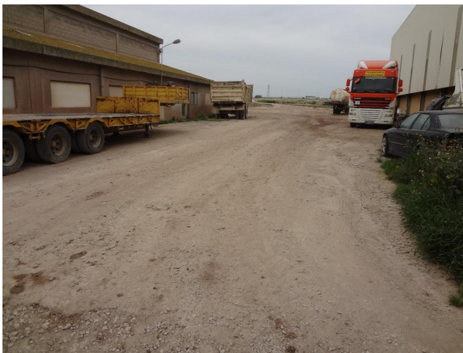
Imagem 7 Zona lateral entre os edifícios, pavimentada com tout-vennant
