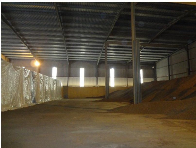
Figura 3 Interior do edifício onde serão instaladas duas caves
